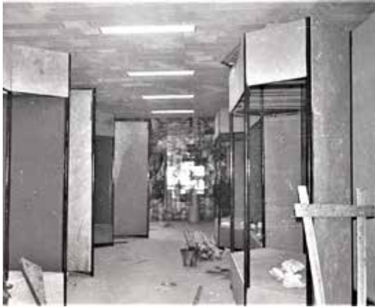
Вітрини відділу новітньої історії в процесі монтажу. Вдалині видніється керамічне панно. Фото Лесі Берестецької, 1982 р.
